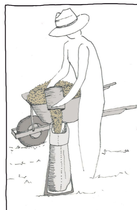
Preparació dels sacs com a element base de la Construcció.
